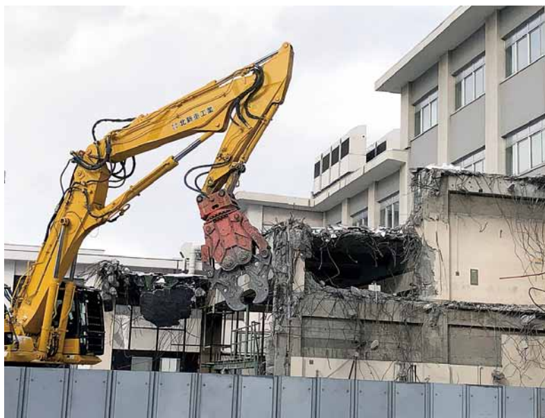
解体工事中の機械研究棟J棟、現在むき出しになっている部屋が藤井の居室
