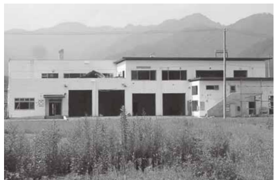
2年前の鶴住居地区防災センター(今はすでに撤去されている)
